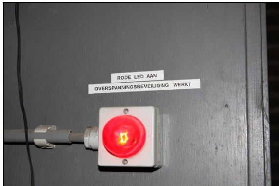
groepenkast met overspanningsbeveiliging
