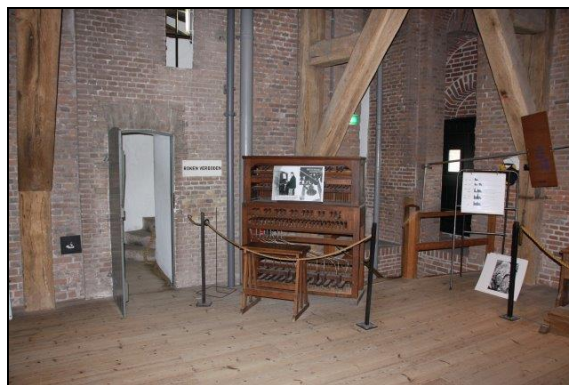
toegang tot (vlucht)trap gesloten structuur van de bovenste etages, maar de deur en het raam zijn niet brandwerend uitgevoerd
