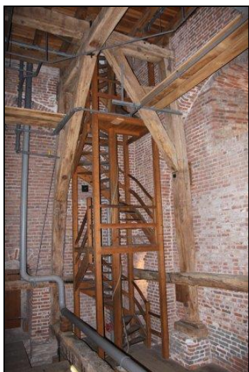
(vlucht)trap open structuur van de onderste etages
