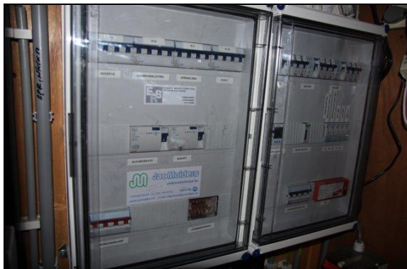
groepenkast met overspanningsbeveiliging
