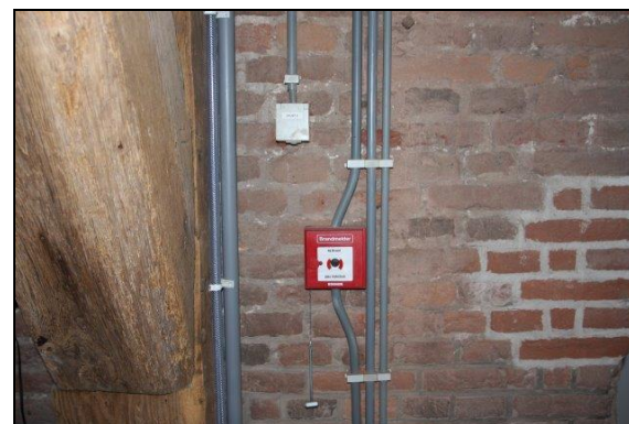
rookmelders en handmelders van de brandmeldinstallatie
